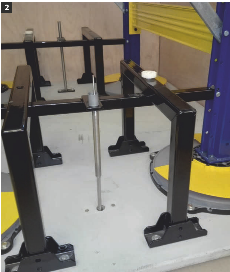
Fig. 2 Dettaglio del dispositivo antisismico, dove si possono riconoscere tutti i suoi componenti (i dispositivi a comportamento lineare, il "CANDLE", gli "UP-LIFT" e la spina fusibile).
